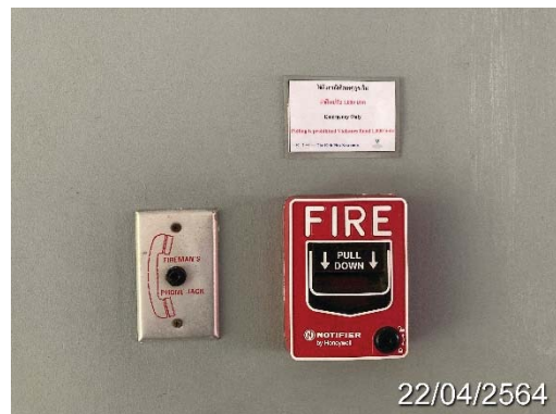
อุปกรณ์เตือนเหตุแบบมือดึง
